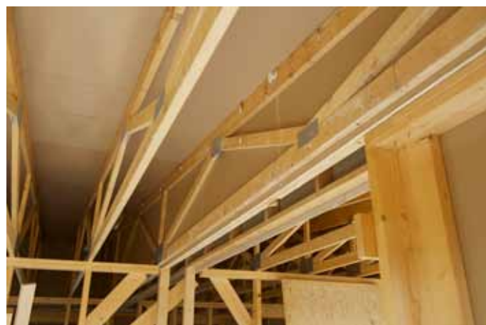
En brannskillevegg er ført helt opp under undertaket på loftet. Over denne, usynlig på bildet mellom under- og overtaket, ligger en hulromsventil med brannstoppmateriale i begge sylindrene.
