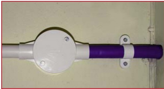
Firoblok® rörlämnare monterad i 20 mm BESA box
